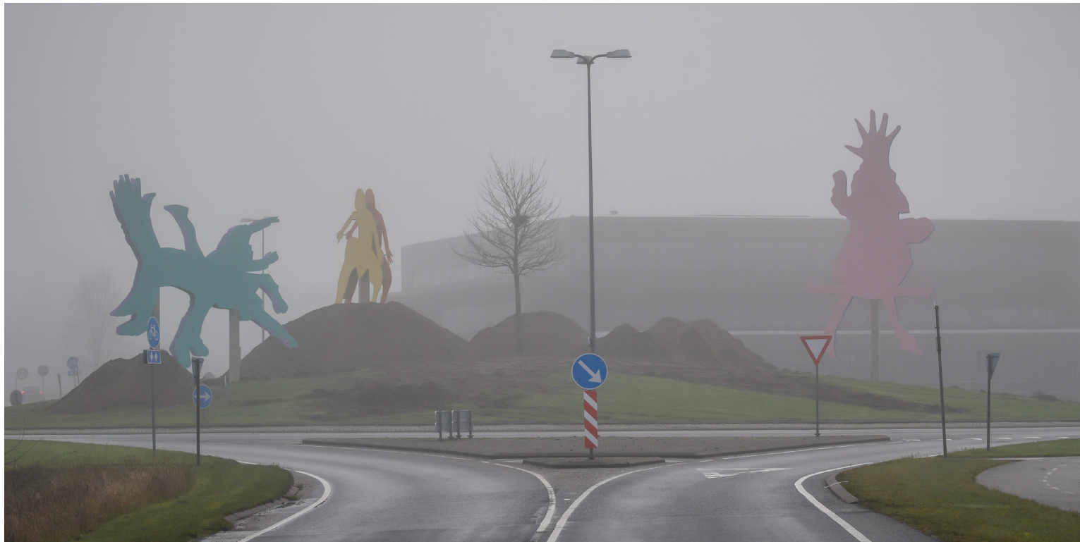
Sans Billund, Rundkørsel Grindstedvej/Saprop. Dagen efter etablering. Jordbunkerne skal udglattes pga trafikudsyn, og lyset kobles til 7 m og 7,5 m og 9,5 m højde stålfuror. Lokal fotograf Johnny Madsen.
